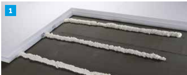
Lijm in ribben aanbrengen...
