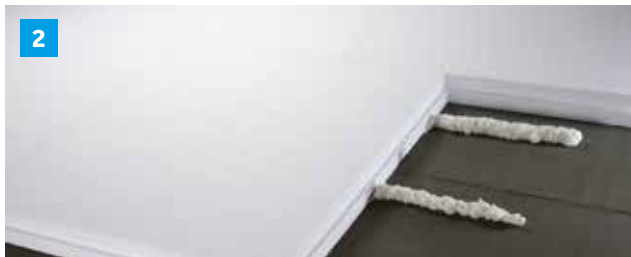
...isolatie plaatsen en aandrukken – klaar.
